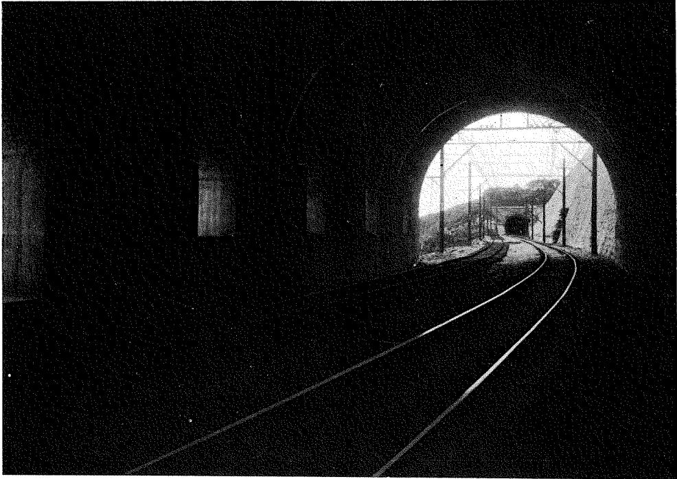
(15) 根府川眞鶴間、赤澤隧道より八本松隧道を望む。
