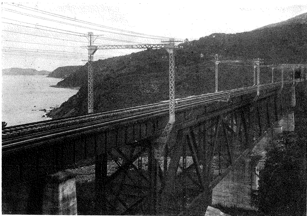
(14) 根府川眞鶴間白糸川橋梁より伊豆半島遠望
