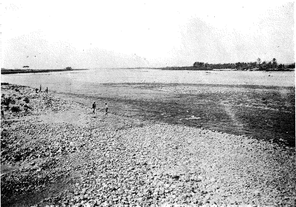
(23) 小牧發電工事用設備 太田砂利採収用吊橋附近の景(2 6 22)
