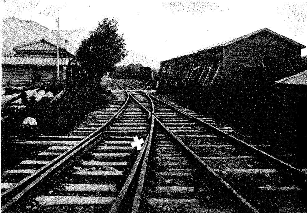
(25) 小牧發電工事 工事用軌道の加越鐵道連絡點鎖錠箇所 (2-8-8)
