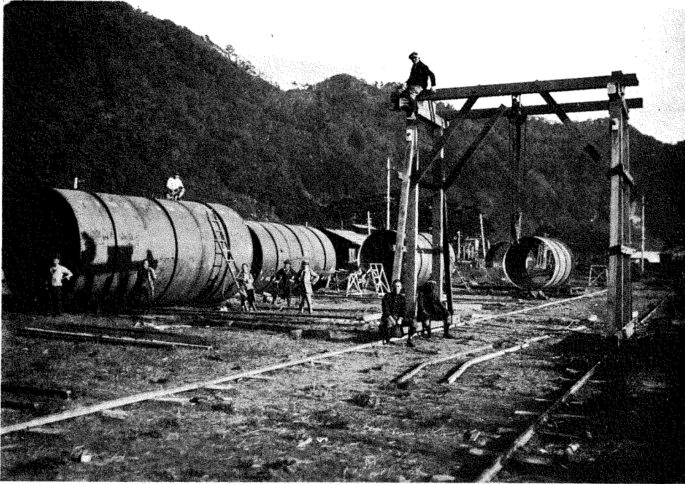
(24) 青島に於ける水壓鐵管製罐場の内徑21呎 管(2-10-31)
