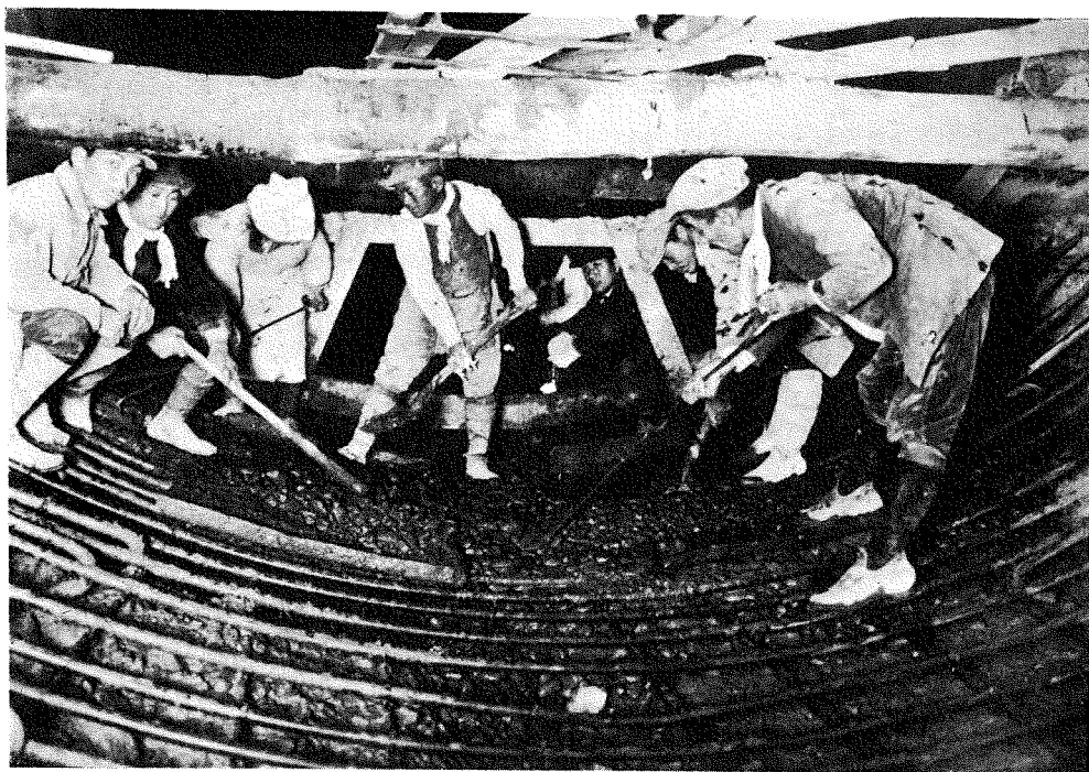
(12) 壓力隧道のインバルト混凝土工事(24-27)
