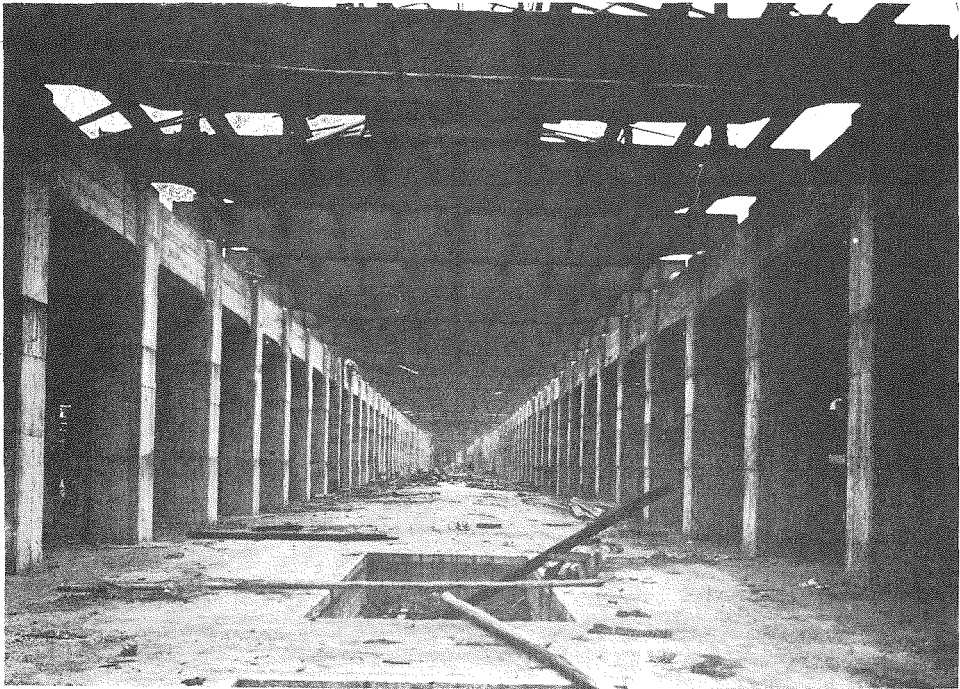
(5) 同上ホームの鐵桁を地階より見たる處 (2-11-4)
