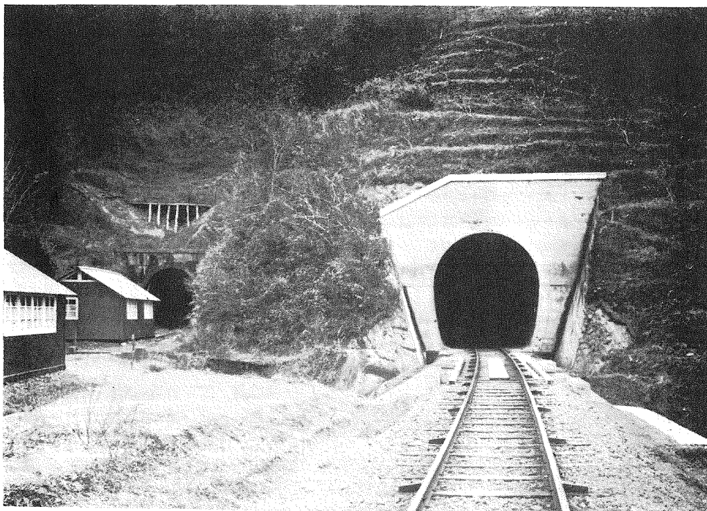
(1) 岩富隧道坑口(ソリッドベッド式道床使用) 左の舊隧道は航空研究に使用さる。
