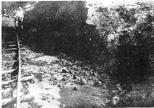
(4) 埋戻し地盤にモルタルの吹出した景
