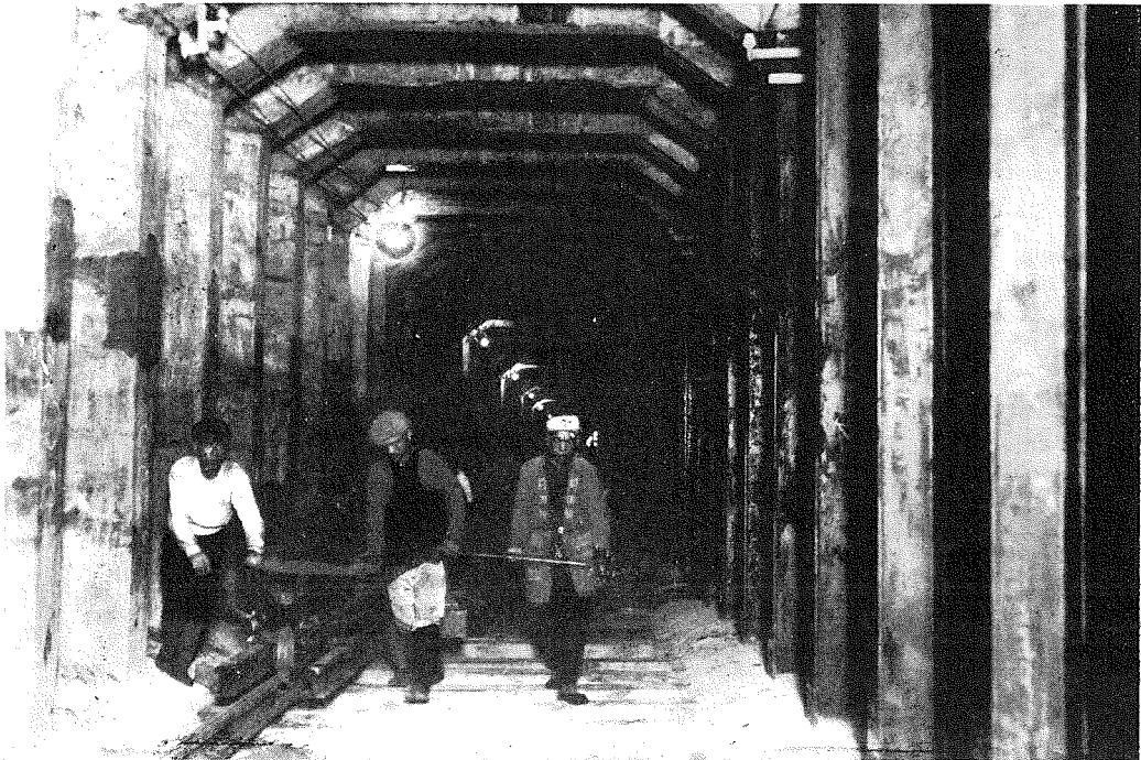
(2) 地下鐵道のレール敷設の景
