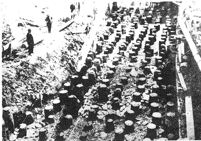
(3) 千住、大橋々臺基礎杭打込
