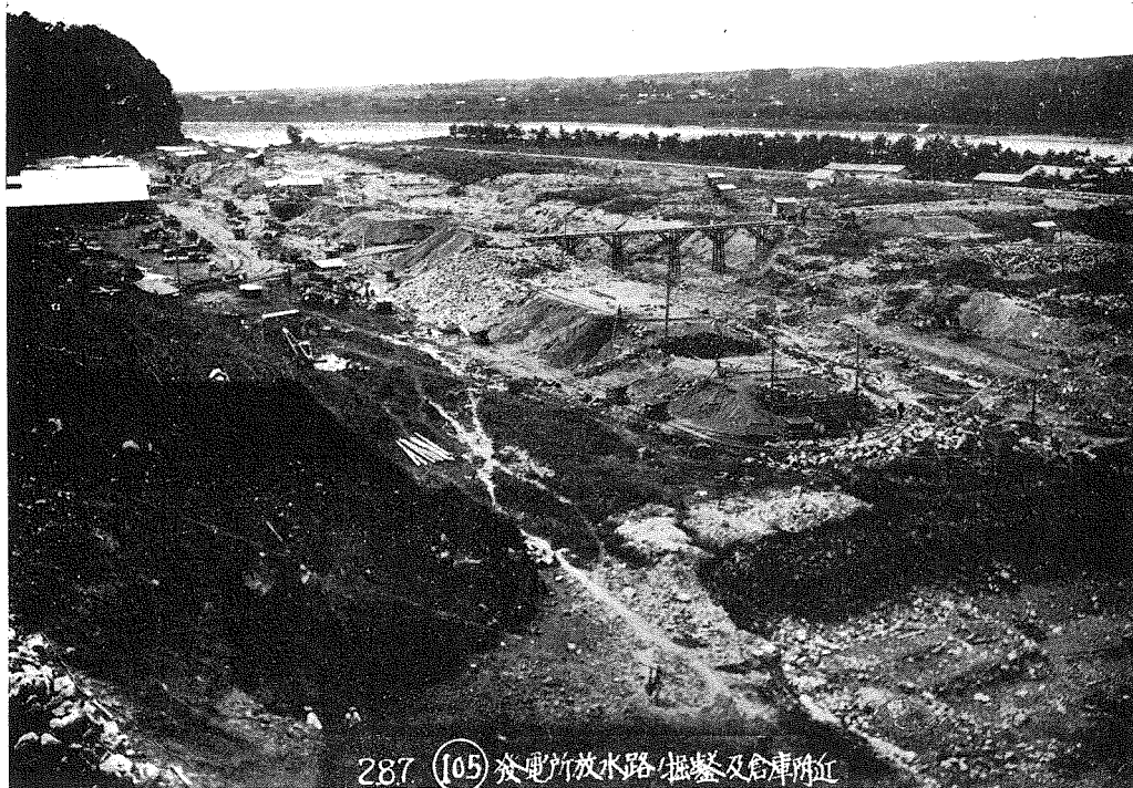
(1) 作久発電所基礎根掘工事及び放水路掘鑿工事中の景
