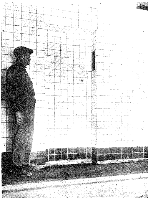
(7) 圖は隧道内に働く者或は其の他の用向にて特に内部に入る者の爲に存する危険退避所なり。
