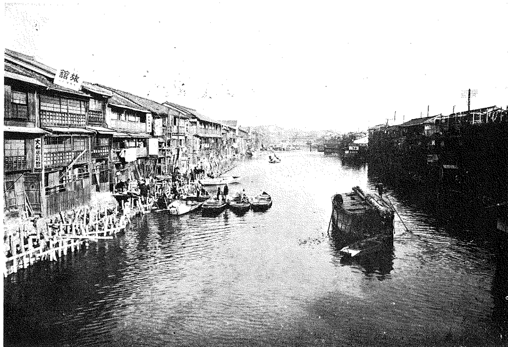
下は施工前(東道頓堀川を日本橋々上より東に向つて望む) Lower- Miserable View of old Water Course.
