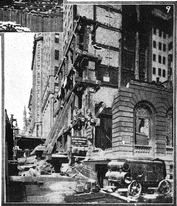
(9) 新らしき位置に押揚げる前の側面の景。
