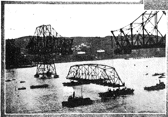
←(4) 午後 2 時 30 分には 750 噸の構桁を臺船から吊上げつつある處で、上の桁の端に黒くカウンターウエイトが下り初めたのが見える。
