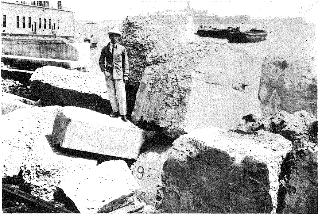
(1) 水中にて爆破裁断せる混凝土塊
