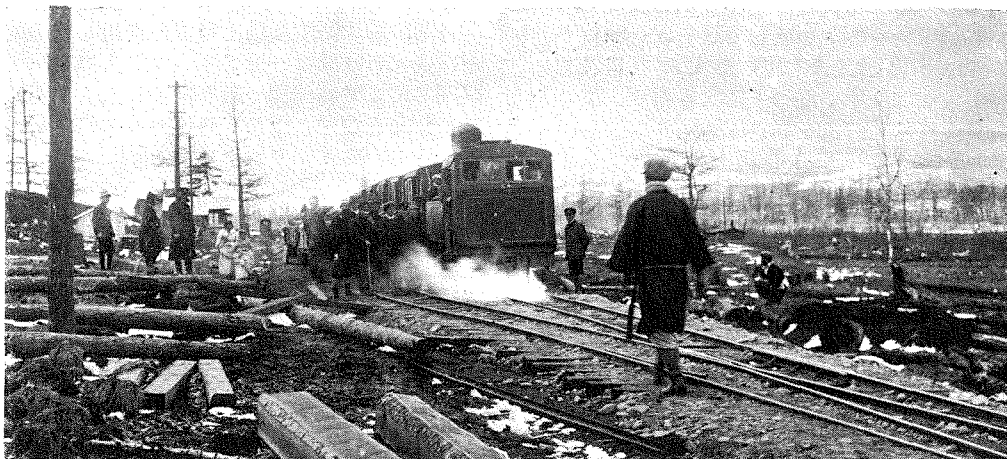
(1) 材料運搬設備の狀況 海抜4400尺の東上面の風景で水電工 事専用鐵道咸地院停車場附近である。
