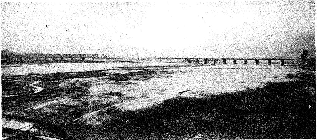
(1) 漢江の鐵道橋全景で、右が龍山の町に接する徑間 60 呎の鋼鈹桁 10 連、中央が築堤部で、左が徑間 200 呎構桁 10 連、三者の全長實に 3,650 呎に及び鴨綠江の鐵道橋よりも長いのである。目下改良工事中のものは橋桁を全部 3 呎宛上昇する事と中央築堤部を鋼鈹桁橋に新設する事である。
