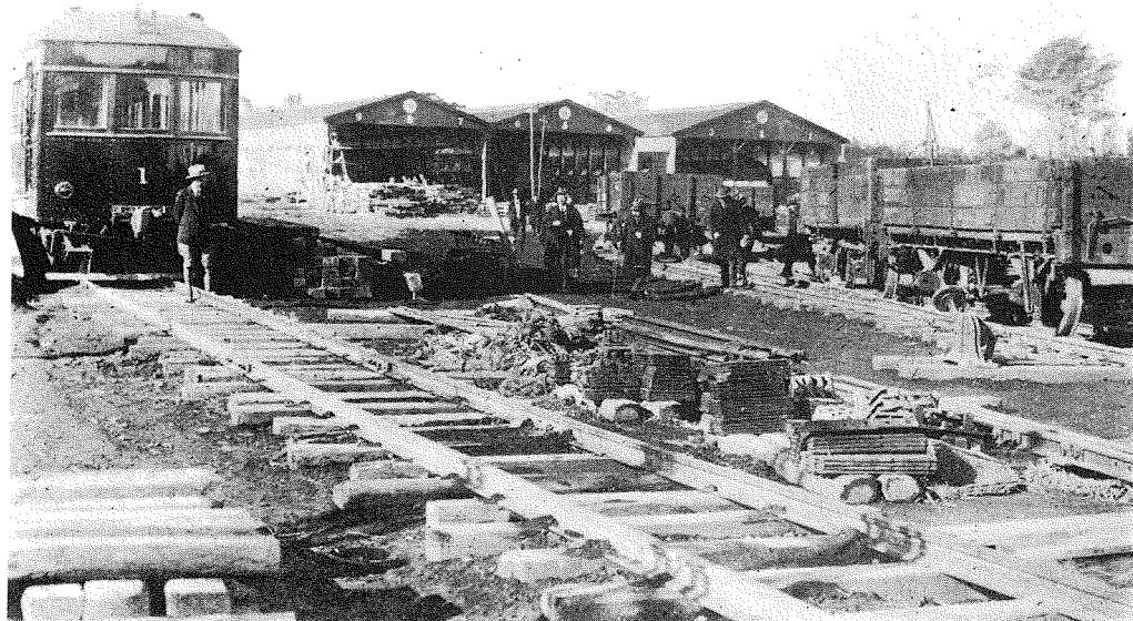
(2) 經堂車庫 新宿より五哩經堂停車場に接続し桁行二百二十五呎、梁間三十八呎の車庫二棟、桁行百八十呎梁間四十八呎組立の工場一棟外に二十四坪の鍛冶工場を設く 1 號客車は長四十八呎幅九呎百人乗電車にして新宿稻田登戸向間運転す。 (2) Kyodo Car-Shed.
