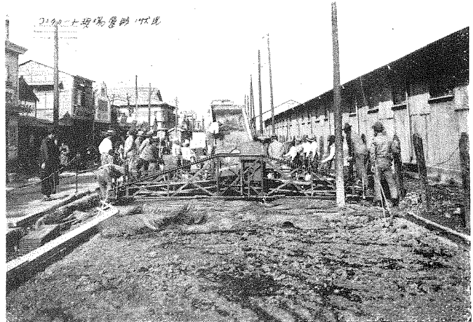
(3) コンクリート現場運搬狀況 (15-10-18) (3) View of Concrete Conveying.
