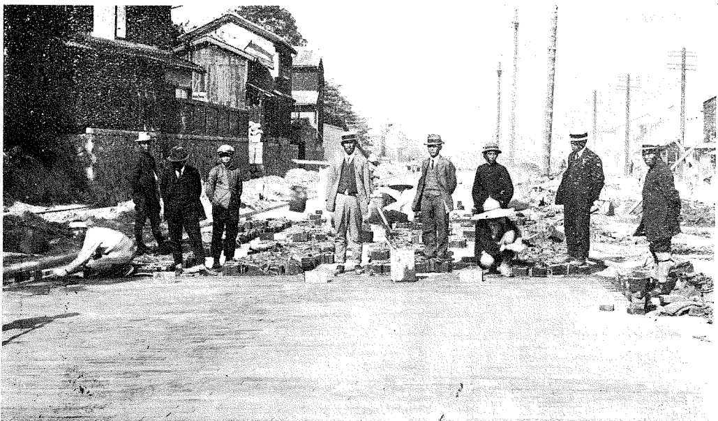
(1) 阪神國道西灘村地内(神戸の隣)にアスファルトブロック鋪裝工事中 (1) Asphalt Pavement Work going on at Nishinada Mura near Kobe.
