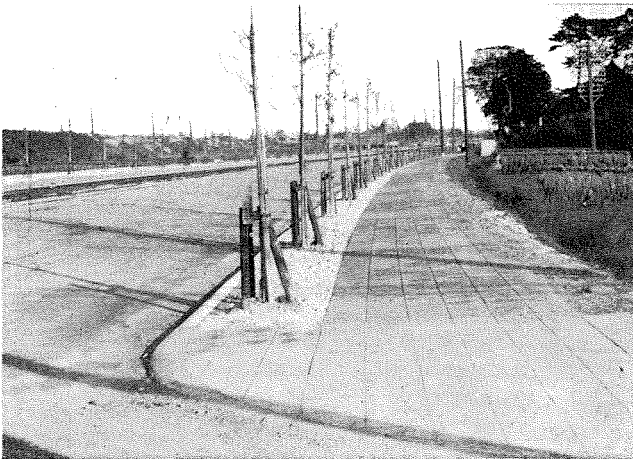
(2) 同上 歩道にコンクリートを碁盤目に舗装したる景 (2) Do. Checker Work Pavement with Concrete Blocks.
