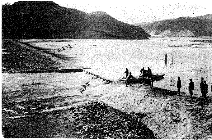
(1) 高梁川東西用水工事酒津取水堰堤
