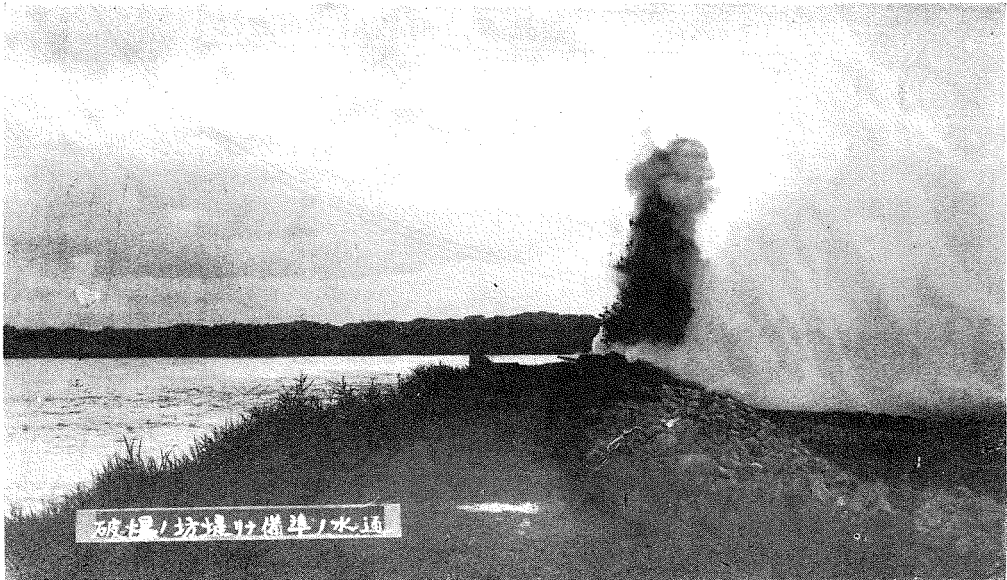
(3) 信濃川分水工事の自在堰工事完成して通水の準備なり妥に舊堤防を爆破して分水路に通水せんとする實景。
