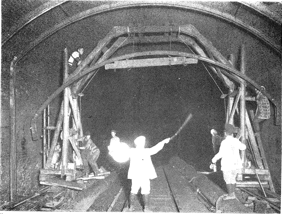
(4) 切擴工事は煉瓦捲の上の岩石を掘鑿するのであるから、先づ坑内から舊煉瓦捲に一時的の支保工を施さねばならぬ、本寫眞は古レールを曲げたものをゴライヤスで吊上げ支保工をやつてをる處である。古レールで片減りがしてをるから一定の曲線に曲げる事が中々困難であり、又一定の曲線に曲げたものが煉瓦肌ピッタリ嵌まらない事があつて工事は中々困難であつた。 (4) Method of Placing Old Rails as the Support.
