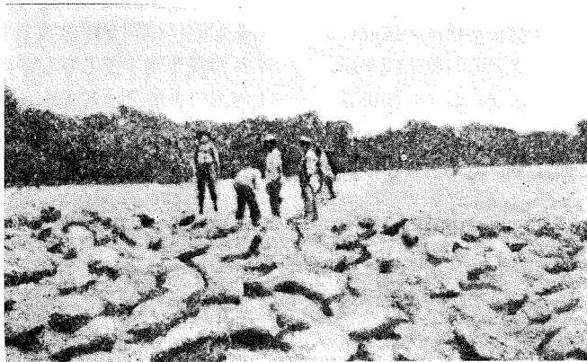
第13圖 混凝土塊の圖 前方は掘り起したる塊の集團 先の方はモルタルの注入を終りたる箇所の景
