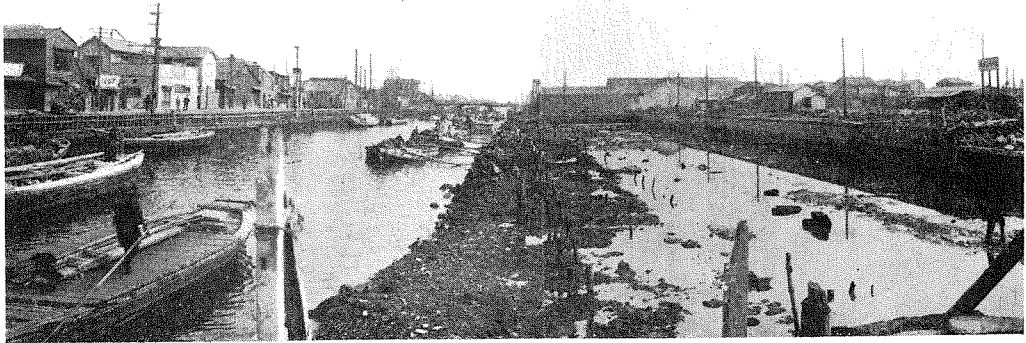
(1) 小名木川筋深川區東大工町地先岸壁工事
