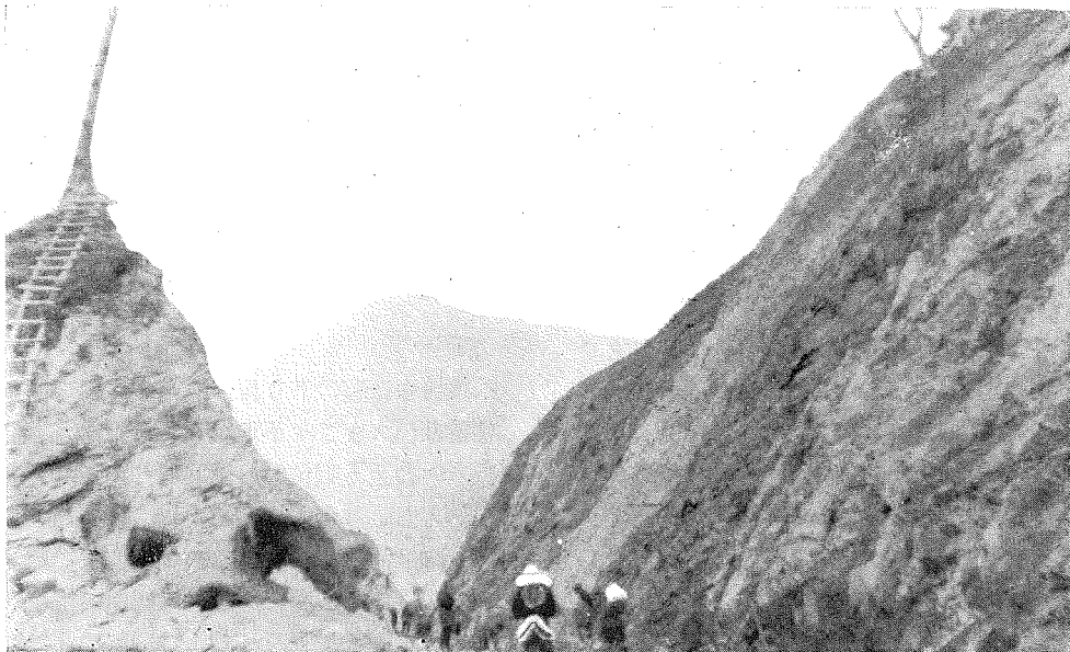
(3) サンダーソン鑿孔機を使用して切取終了後の現場 (3) A View after Excavation Completed.
