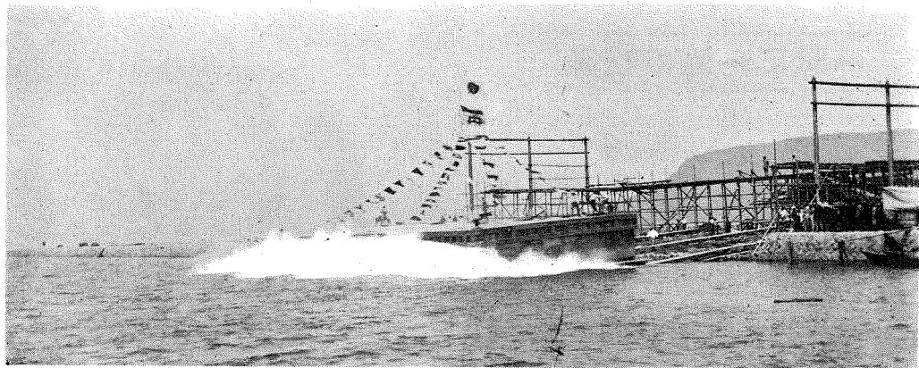
(1) 高松港鐵筋混凝土浮桟橋進水の光景。
