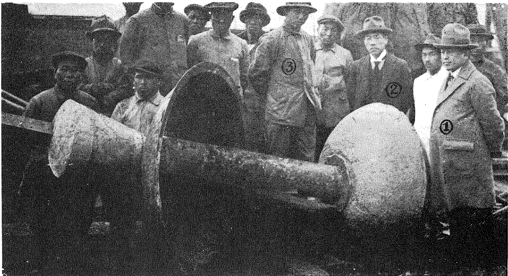
(14) 第二號供試體（塊狀基礎）の外皮の鐵板を除きし所。供試體の外壁は厚十六分の一吋と同八分の一吋の鐵板よりなれり、而して是等鐵板は單に内部の混凝土が凝結する間だけ必要にして其の後は別に無之とも可なり、實驗の結果によれば供試混凝土は施工後僅か一箇月餘なるに拘らず其の何れの部分も甚だ良好に成形し且つ凝結せり、従つて此の場合鐵板は施工後月餘にて腐蝕し盡すとも何等支障なかるべきを確めたり。 寫眞中の人物。1 發明者 白石技師。2 石川島造船所設計部長 佐伯技師。3 同所 土屋技師 (14) The Foundation No. 2
