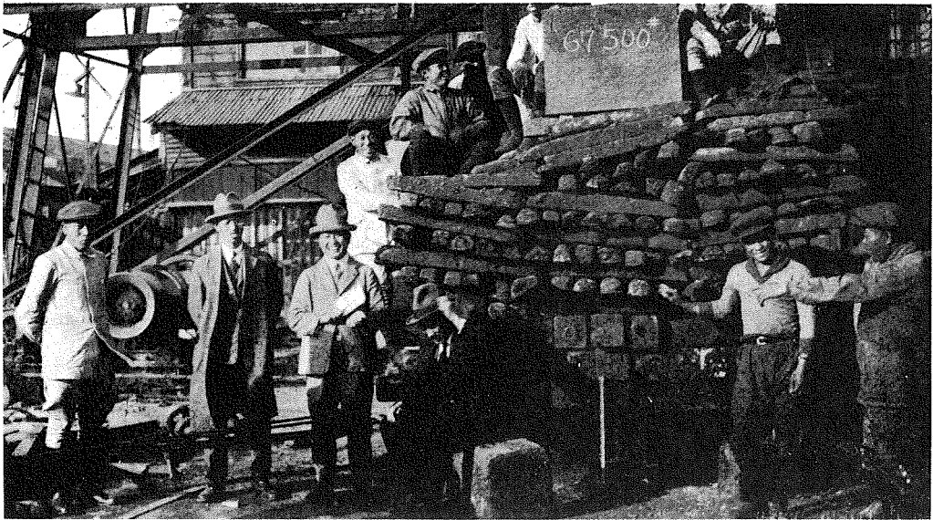
(15) 第二號供試體（外皮の鐵銹を除去せる塊狀基礎）に參拾英噸の下壓力を加へし所。
