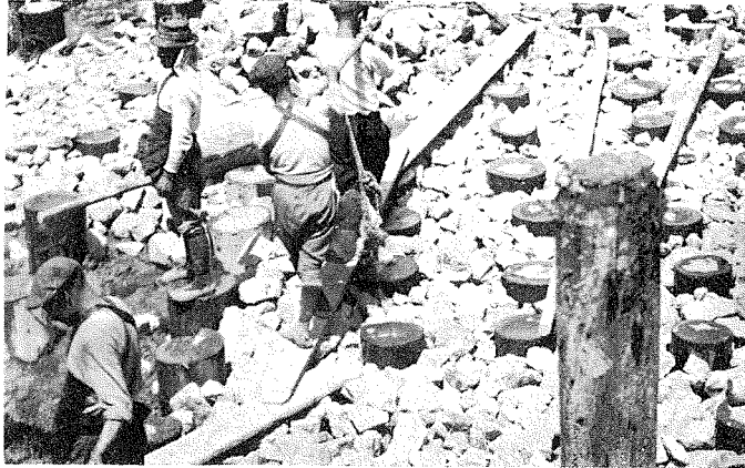
(5) 煙突基礎割石入 (14年5月31日) 面積二千二百四十平方呎の八角形、杭は末口九吋五十呎二本繼ぎにて九十五尺打込三尺間にて一本十五噸の耐重。割石一尺五寸厚。
