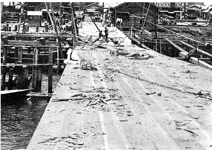
(10) 工事用假橋及び作業と材料置場を兼たる棧橋臺。
