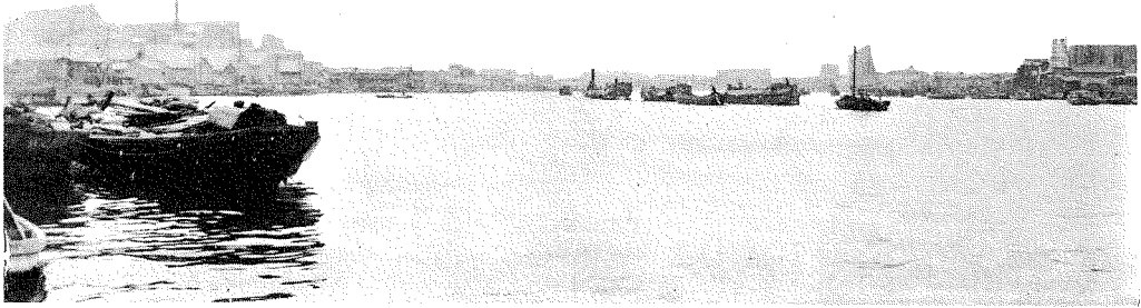
(2) 清州橋架橋箇處
