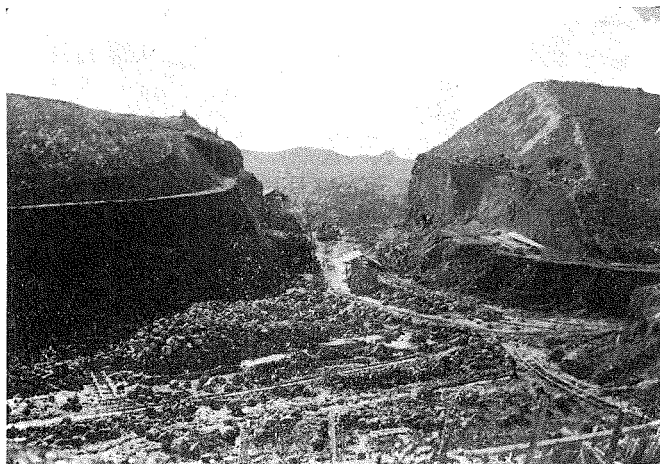
(19) 第四發電所水槽掘鑿の景
