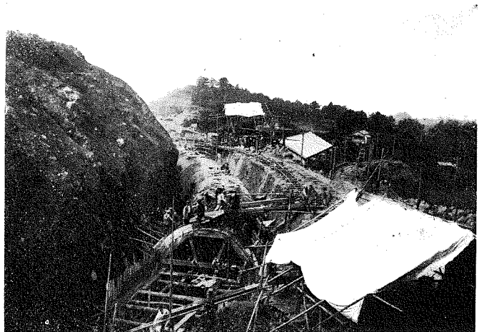
(9) 第三發電所暗渠コンクリート捲立の景
