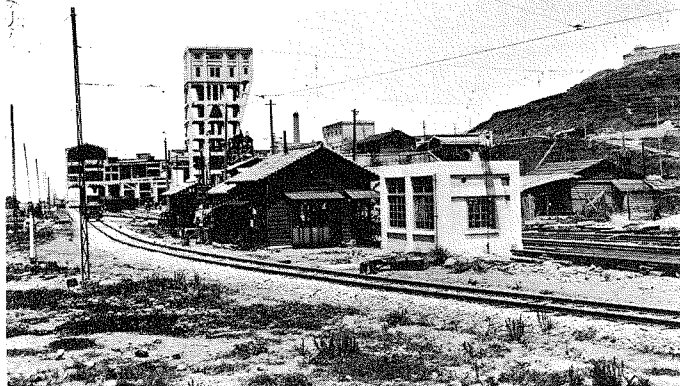
(?) 三池炭礦の整頓に据付たる秤量三炭廐にして數多の車輛を連 結計量す (?) Car Scales At the Miike Coal Mines.
