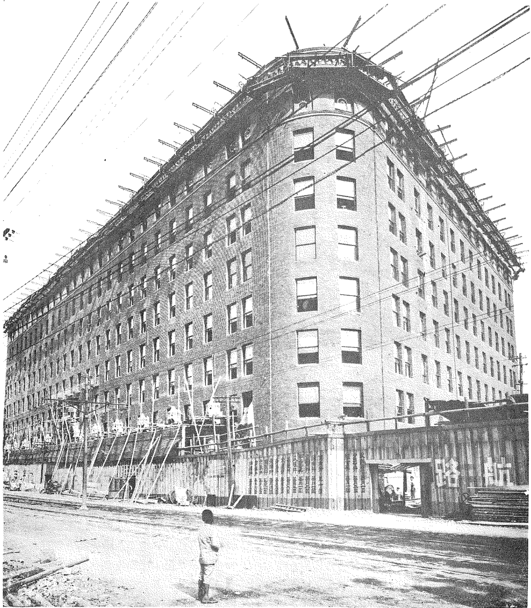
(I) 八階仕上工事
