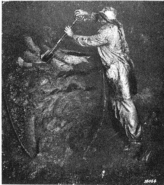
(B) 粘土の切取掘鑿に對しては此のニューマチックのクレデツガーが最も適當してゐる。ニューマチックによる費用は手掘でやる費用の約三分一強である。（インガーツルパンフレットより）
