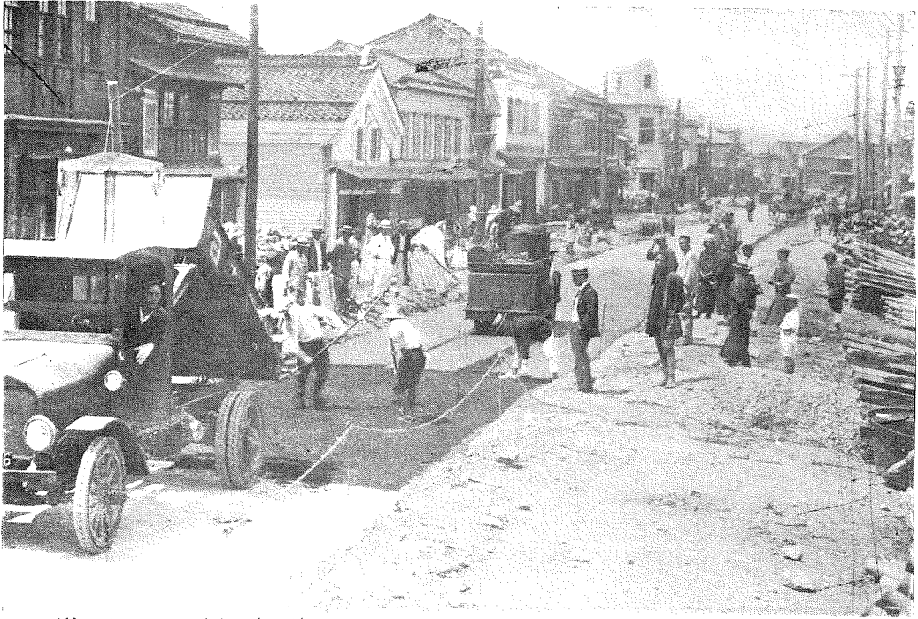
(1) 函館市南町道路中央二間半のアスファルト表層の撒布及ローリング
