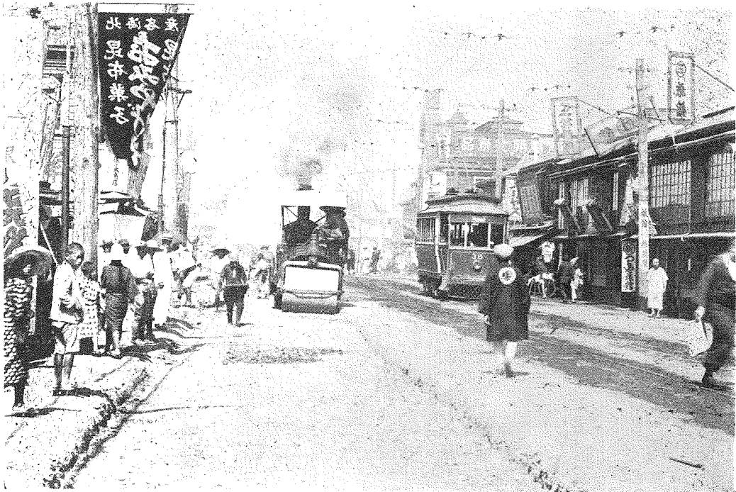
(4) 同上音羽町電車兩側間のアスファルト舗装工事
