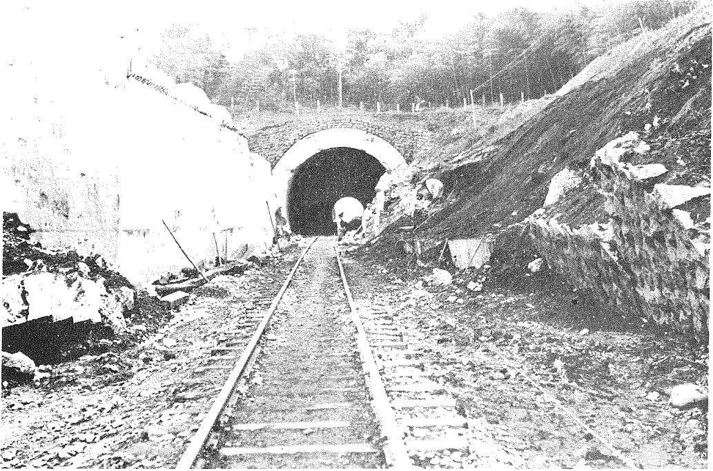
(11) 熱海線小田原早川間小峰隧道東口破壊箇所復舊工事中の實況
