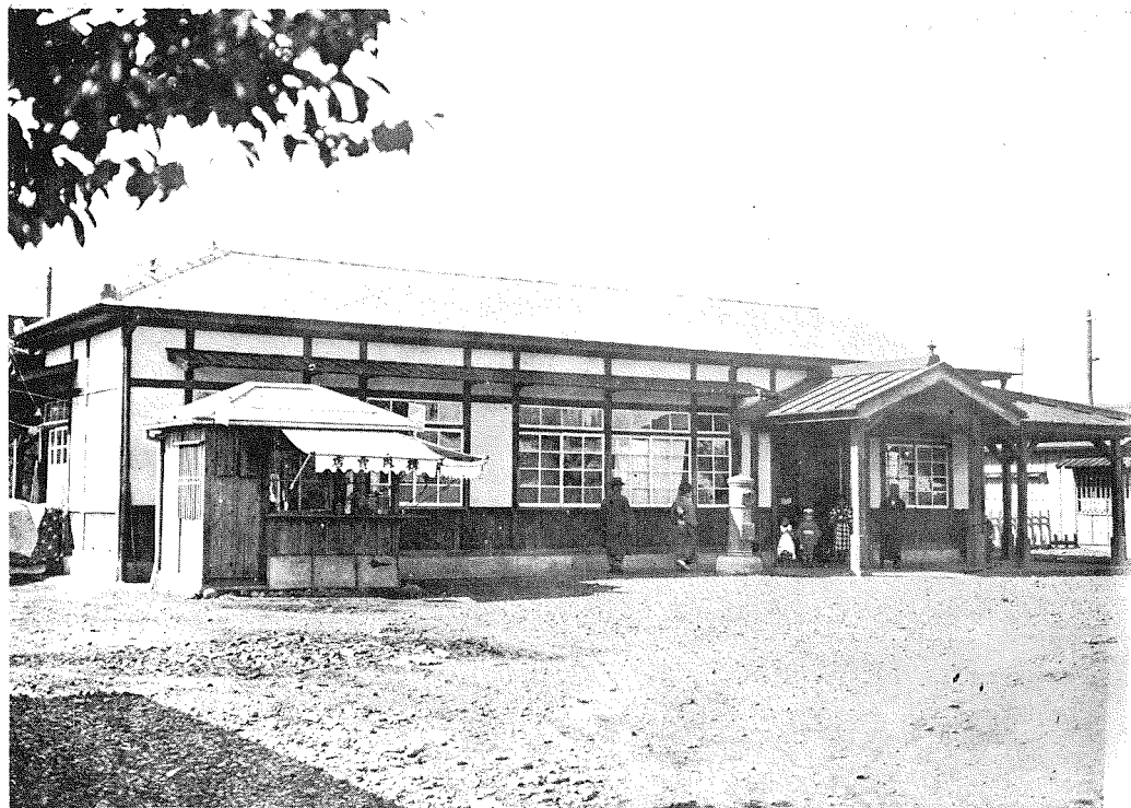
(14) 熱海線早川驛木屋復舊後の現況
