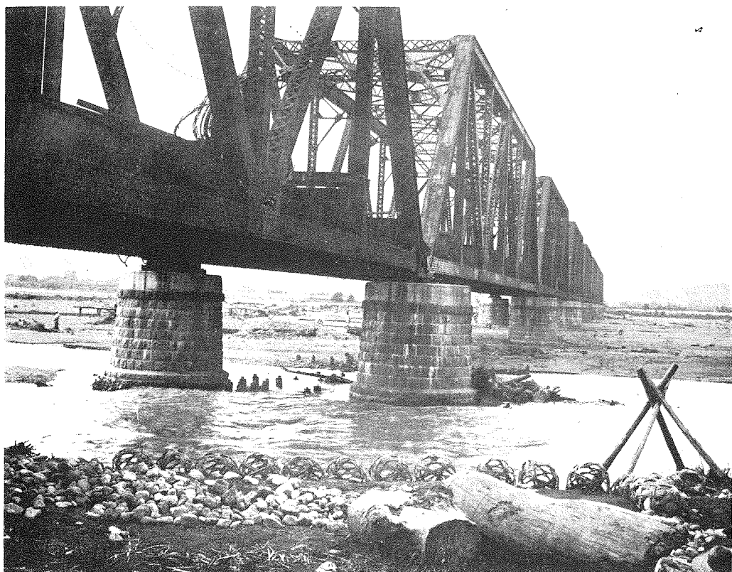
(9) 熱海線鴨宮小田原間酒匂川橋梁復舊工事竣工後の全景
