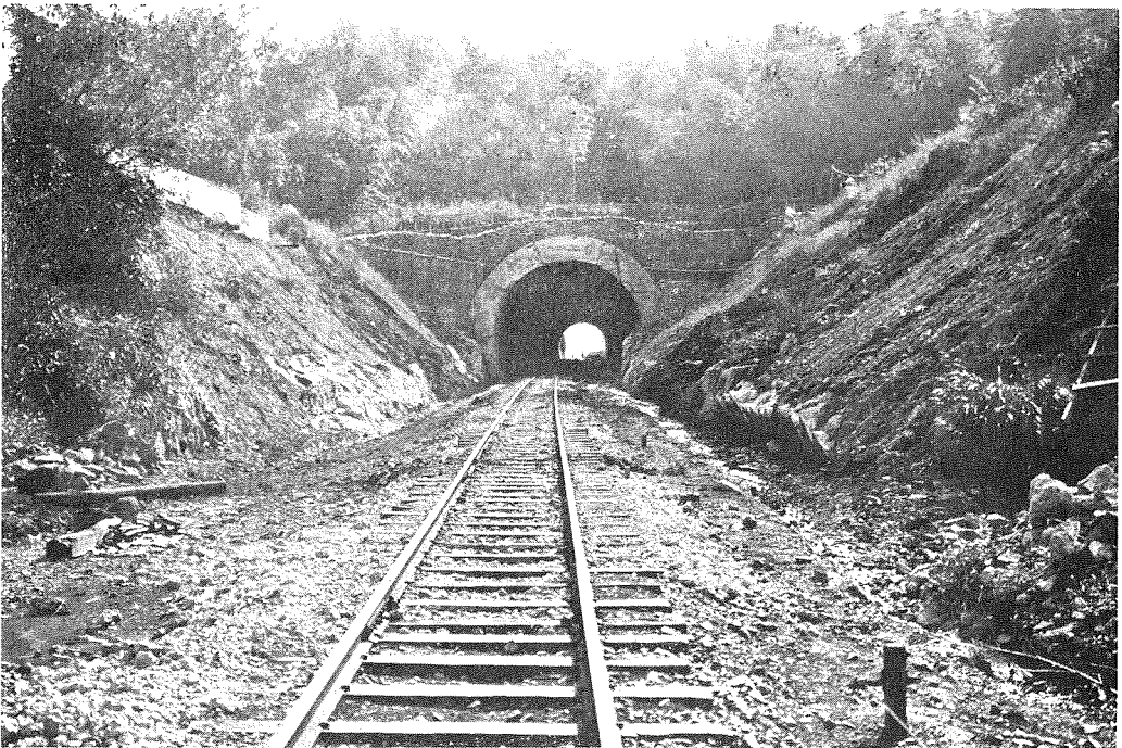
(12) 熱海線小田原早川間小峰隧道東口坑門復舊工事竣成後の現況
