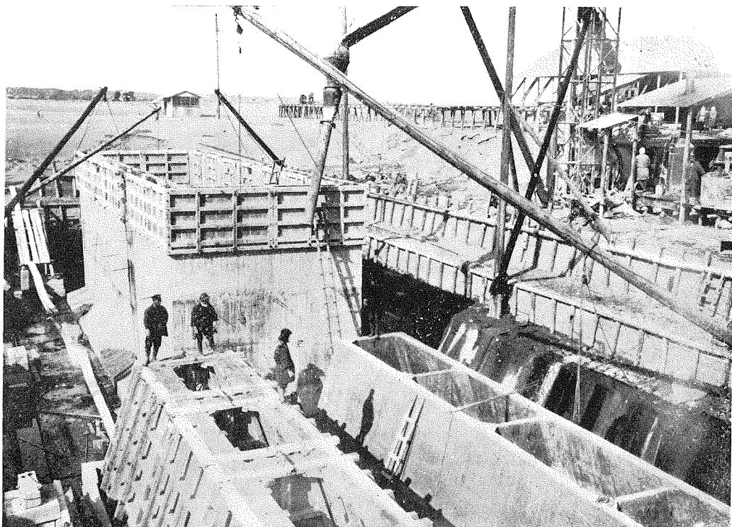
(8) 乾船渠内防波堤用鐵筋コンクリートケーソン製作中、乾船渠長150尺幅40尺深千潮面以下11尺
