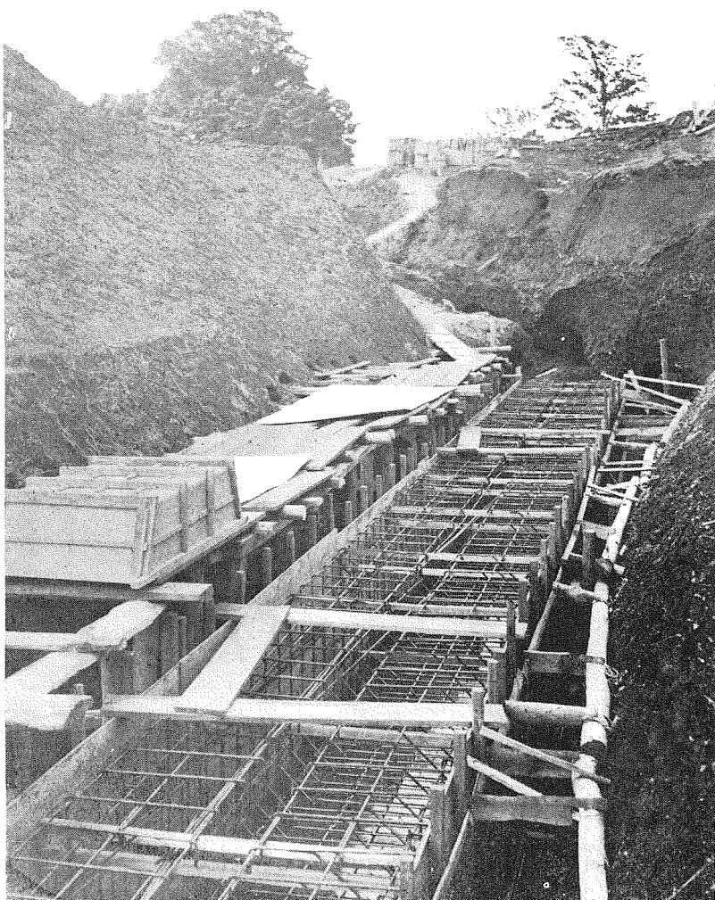
(6) ボックスカルバート築造工事 (6) Culvert Under Construction.
