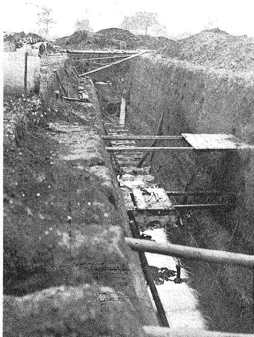
(5) 排水管埋設工事
