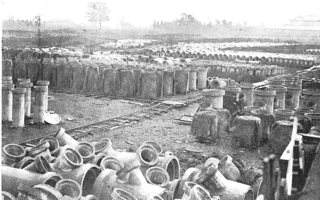
(4) 鐵筋コンクリート管製作工事
