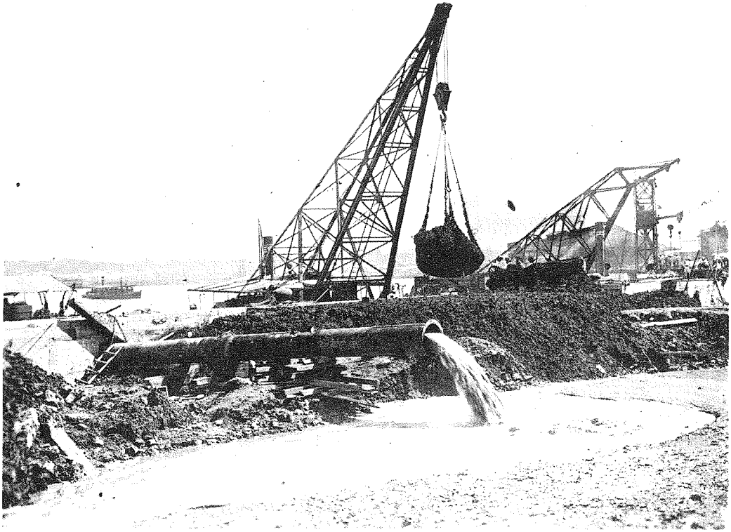
(20) 唧筒式浚渫船にて埋立中
