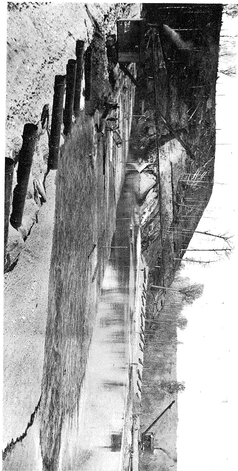
(6) 堤高二百六十呎の純土堤堤の築造工事中である。左方及び右方のスチームショベルは沈澱したる土砂を取つて兩側に盛土をなしつゝある。兩スチームショベルの前に流出管口があつて今盛んに土砂を流出して来る管から流れ出た砂利や小石は早く落付いて、細縫の粘土質のものは水と共に中央に流れ沈澱する、而して此の沈澱物が純土堤堤の心壁部分をなすのである。
