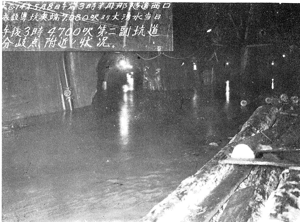
(1) 大正十四年五月八日午前三時半丹那隧道西口底設導坑奥端七〇八〇呎より大湧水、當日午後三時四七〇呎第二副坑道分岐點附近の状況。
