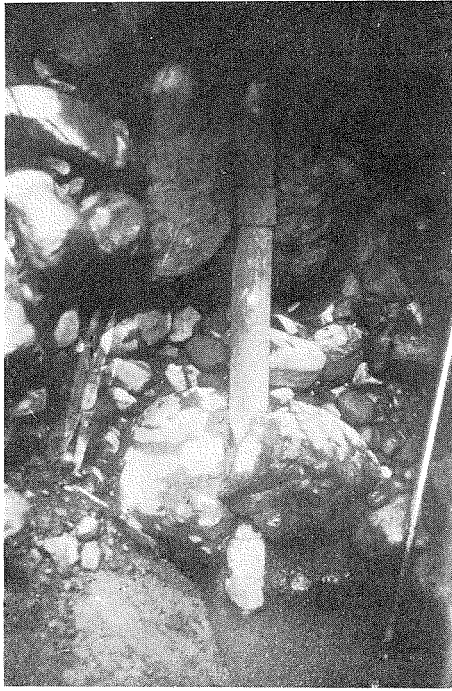
シユウにて玉石を打抜きたるもの Drill Pipe Penetrates a Boulder.
