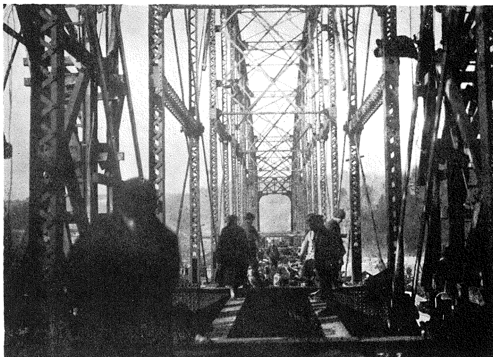
北上川架橋工事(5) 三百呎トラスのフロアービーム取付中(十三年一月七日)
