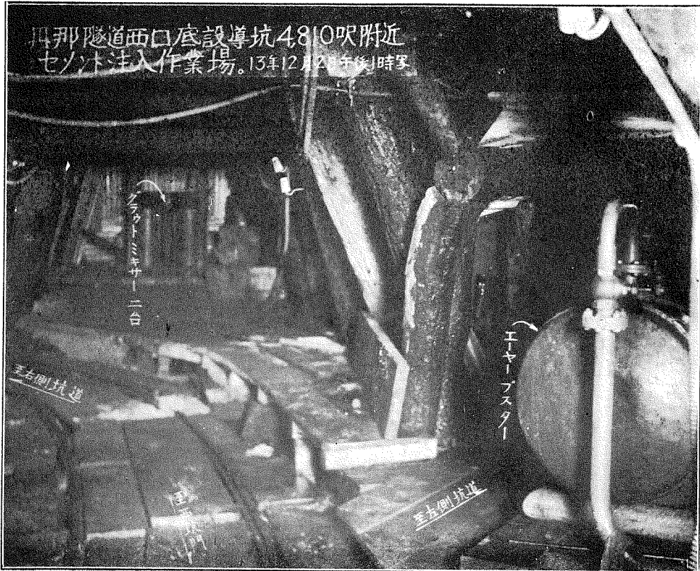
丹那隧道西口坑内
