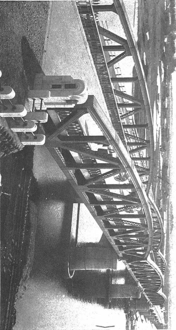
位置 國運十號路線 山形縣東田川郡横山村 橋長307米45 有效幅員7米5 橋格二等橋 橋種鋼桁橋 橋徑間
