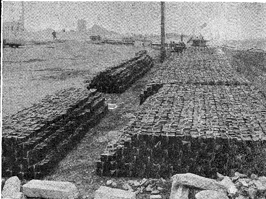
国道十六號線大和川橋工事現場
