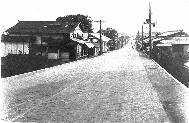
同所小鋪石滑止鋪裝施工中ノ狀況 平均厚 21 糎 施工順序下層 1:3:5 10 糎厚 褥層モルタル 1:2 2 糎厚 下層 1:3:6 4 糎厚 上層 1:1.5:3 5 糎厚
