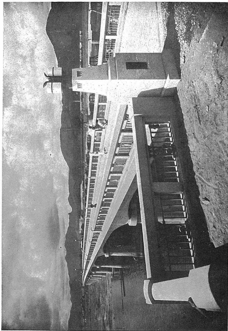
橋長二百九十分米有效幅員五米五〇、橋面アスファルト舗装上部構
