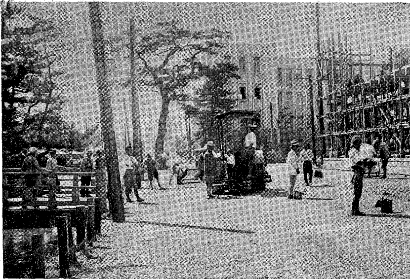
新潟縣廳前鋪裝工事狀況
